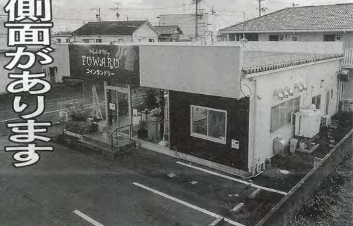
店舗外(右)に受水槽などを設置した災害対策ランドリー(TOSE | 提供)
