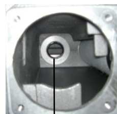
ポンプ内に張り付いたOリング
