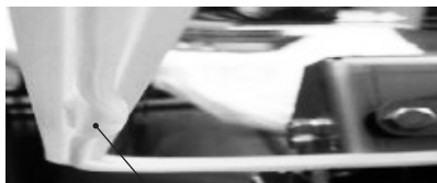
めくれている箇所が無い確認
